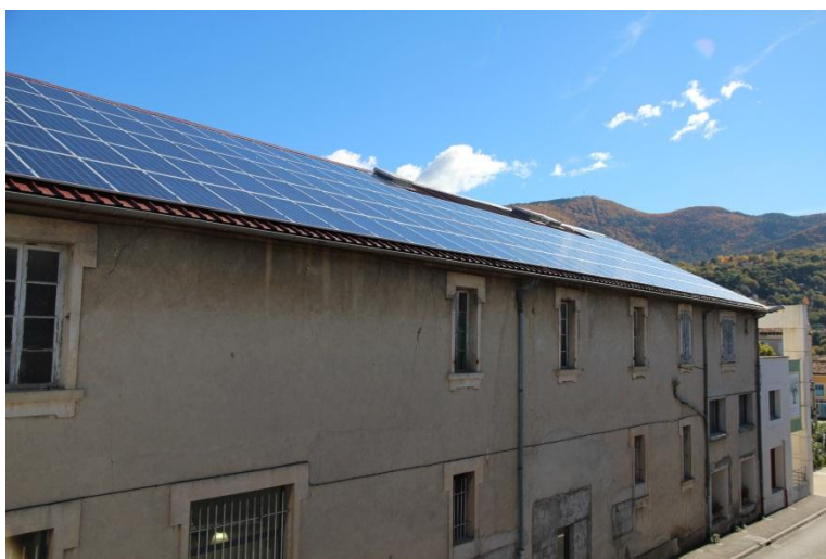
Vue d'une toiture de la Coopérative du Nyonnais, rénovée avec des panneaux photovoltaïques avec le concours de CAM Énergie Sud Rhône Alpes
